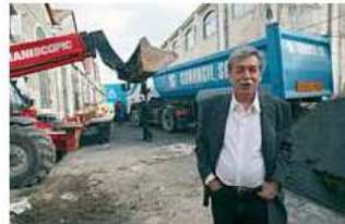
O autor do futuro Museu dos Coches, na quinta-feira, rodeado de maquinaria que fará as demolições das OGME
