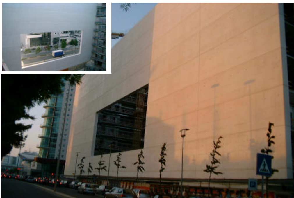
Figura 7 – Perspectivas da viga parede em betão branco
