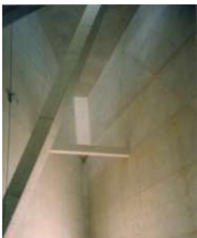
O apoio vertical das lajes do lado Sul, que na zona do átrio existem entre a fundação e a escada de acesso ao Auditório principal, e na faixa atrás referida até à cobertura, é constituído pela casca exterior, a parede principal longitudinal Sul, o referido plano vertical com 0.35m de espessura e ainda o pilar inclinado que “cruza” o espaço do átrio.
