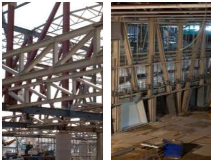
As grandes paredes longitudinais da caixa albergam as treliças principais, que tiram partido de toda a altura do Edifício. É ao longo destas paredes que se localizam os grandes eixos de distribuição dos serviços, interligando as duas zonas técnicas do Museu, localizadas em espaço aberto nos extremos do nível superior.
