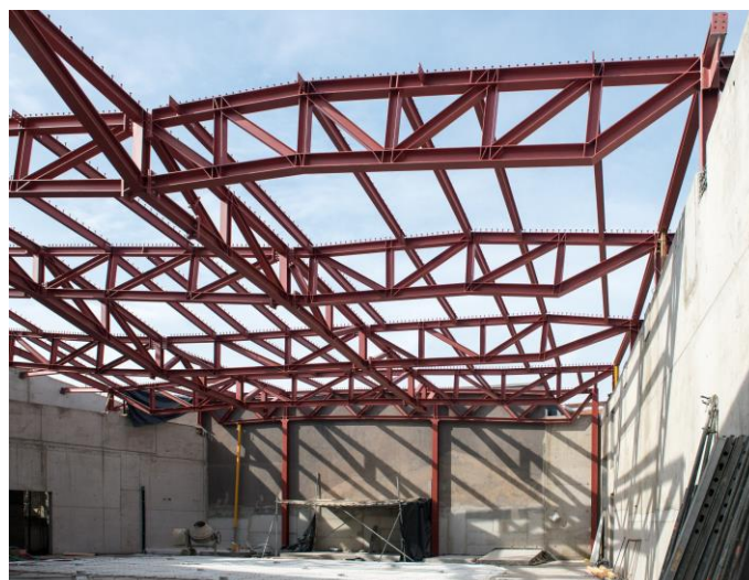
Imagem 5 - Treliças da cobertura do "Project Room"
