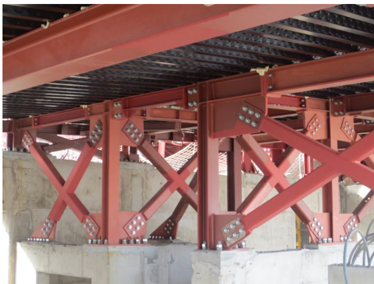
Imagem 6 - Travamentos da cobertura
