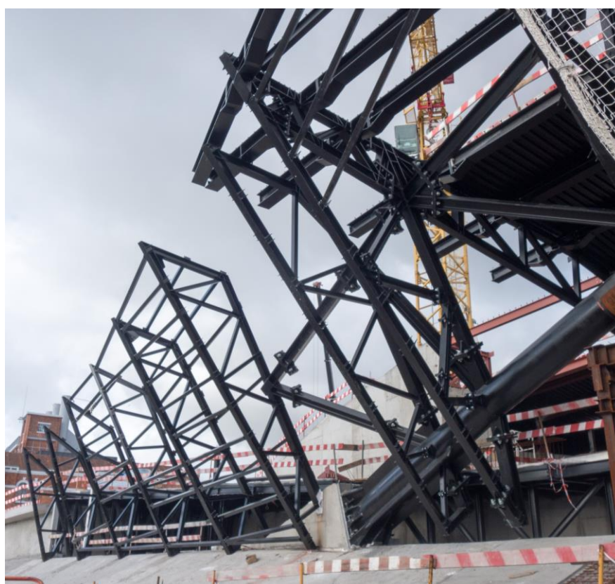
Imagem 11 - Estrutura de suporte à fachada Sul
