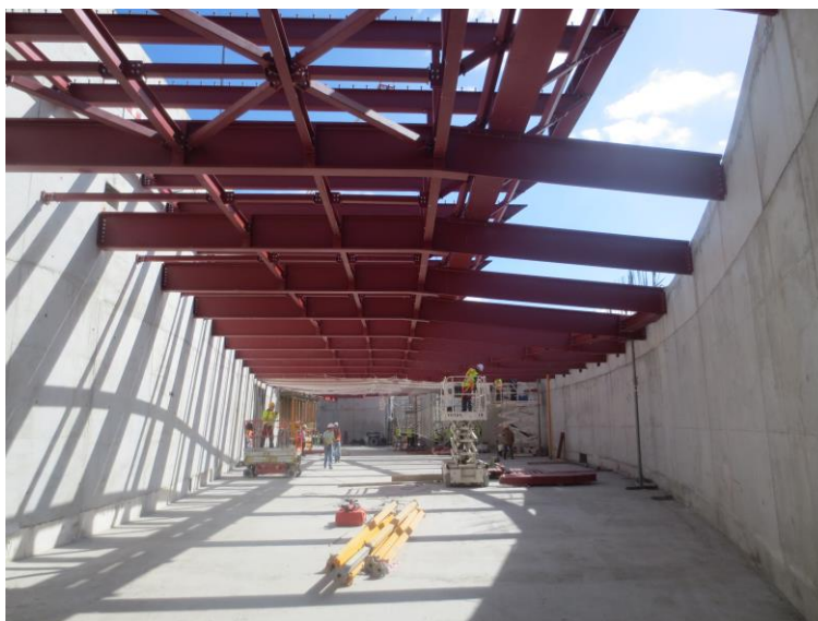
Imagem 3 - Vigas de apoio da claraboia da "Main Gallery"
