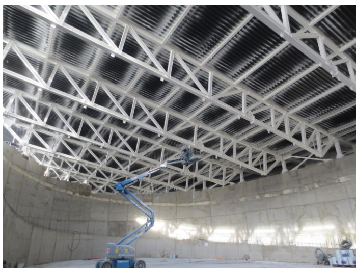
Imagem 4 - Treliças de cobertura da "Oval Gallery"
