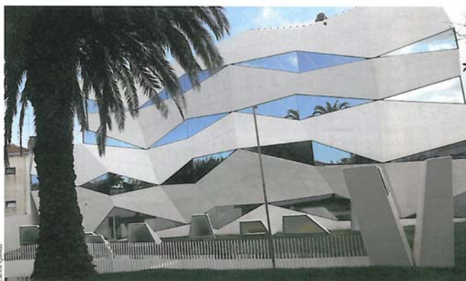
Envolvente do edifício em betão armado aparente
