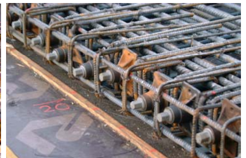
Armaduras de pré-esforço e armaduras passivas da “Ponte”
