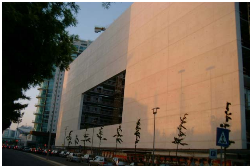
Viga parede em betão armado
