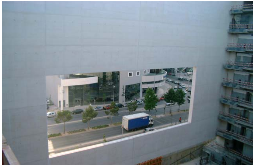
Viga parede em betão armado
