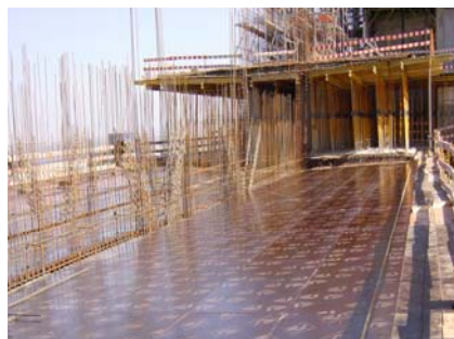
Armaduras de pré-esforço e armaduras passivas da “Ponte”
