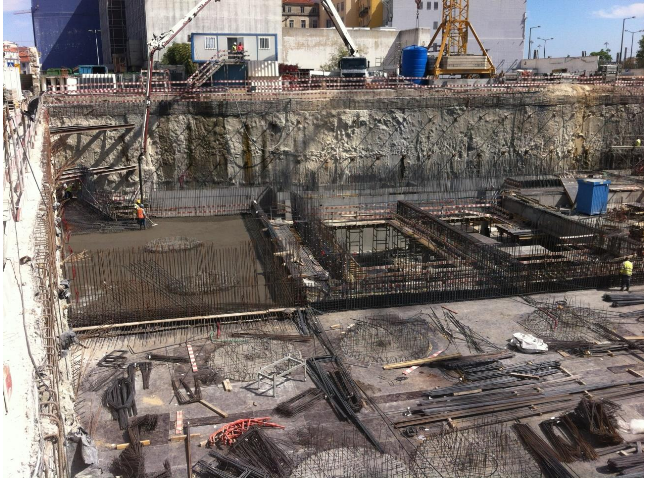
[Construction de dalle – étage -3]
