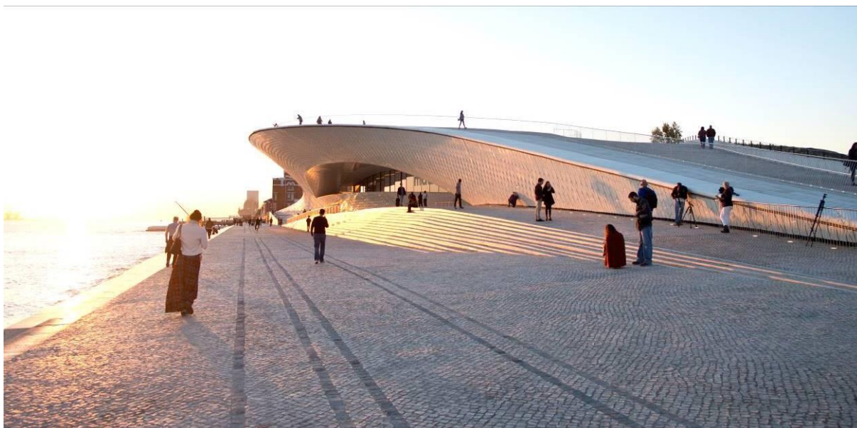
Fig. 1: Vista ribeirinha do edifício
