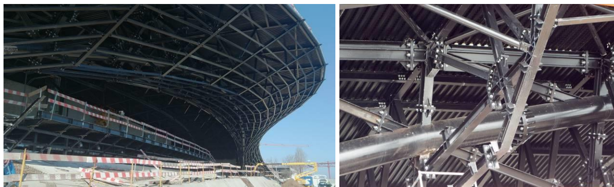
a) Vista geral da estrutura completa
